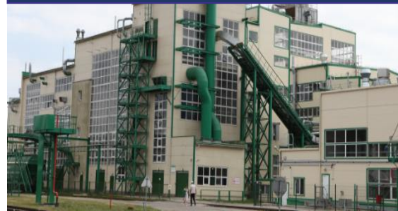
Завод по производству концентрата соевого белка (SPC-200)
