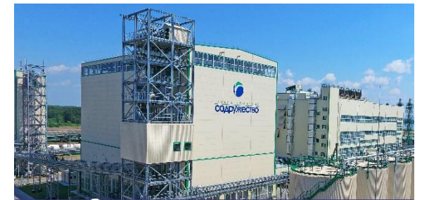
Завод по производству концентрата соевого белка (SPC-500)
